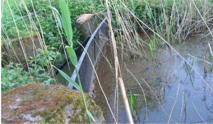
**Photo n° 7** : Exemple d'une grille bouchée par les végétaux véhiculés par les eaux (Mai 2005)
